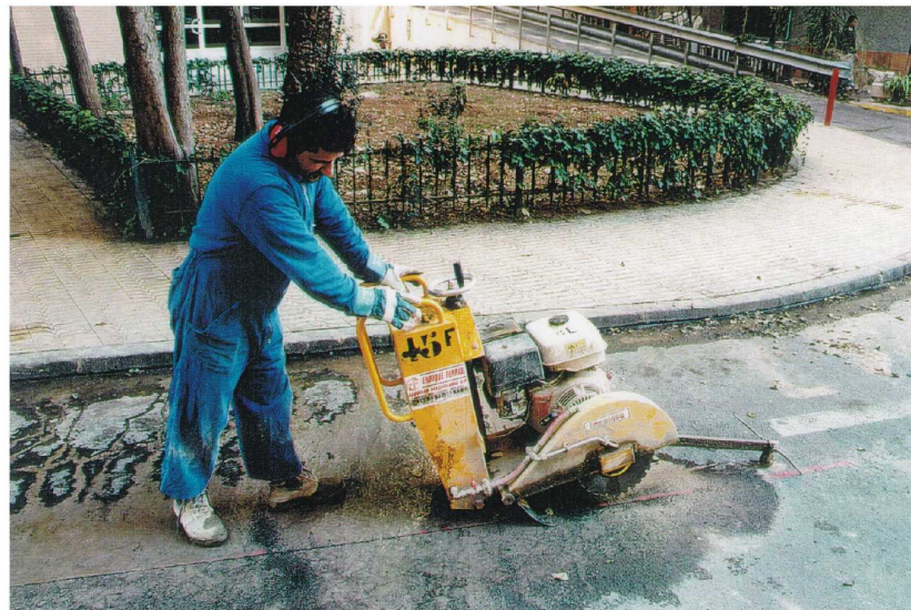
CORTE DEL PAVIMENTO ASFALTICO
