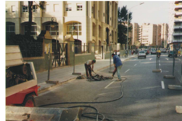
DEMOLICIÓN MANUAL LOCALIZACIÓN DE SERVICIOS
