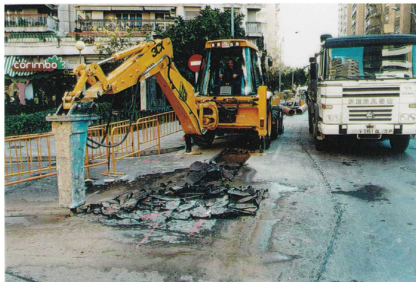
DEMOLICIÓN MECANICA DE PAVIMENTO ASFALTICO
