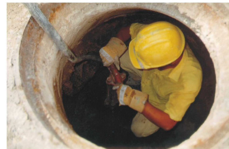
DEMOLICIÓN MANUAL EN INTERIOR DE POZO
